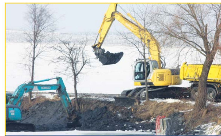
Das Teichbecken wurde rasch und kompetent ausgebagert, die Böschung begradigt und wucherndes Gestrüpp entfernt.
